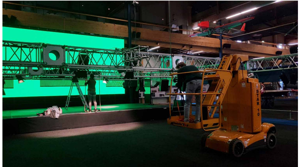
Montage des Trapezes am Traverse.
